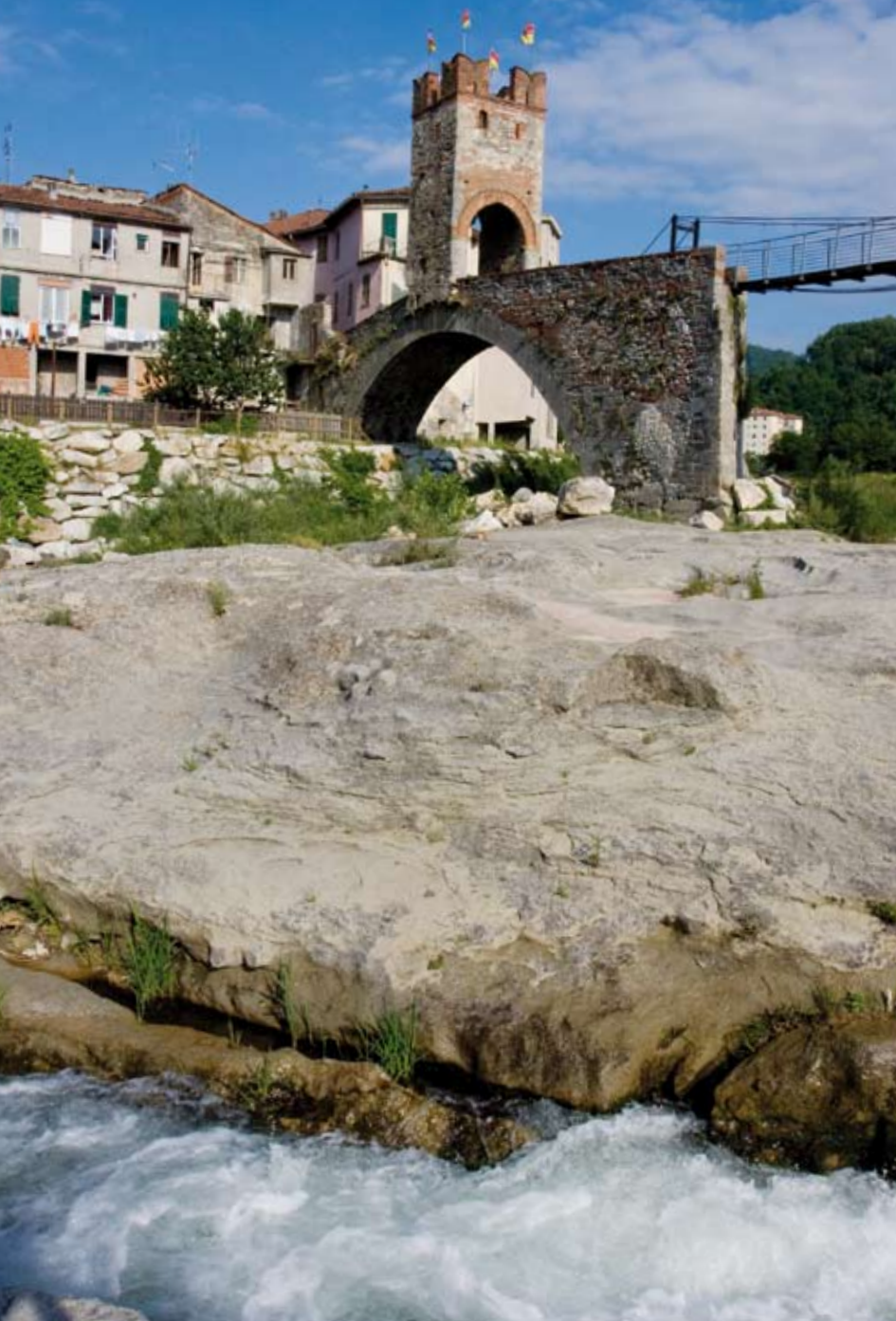
Millesimo, ponte sul fiume Bormida (Sv).
